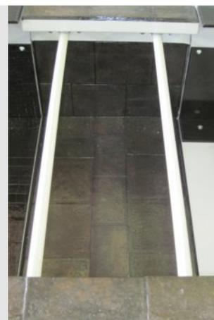
Auskleidung mit Schmelzbasalt
